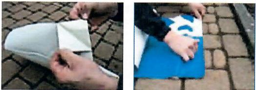
4. Asphaltfolie an einer Kante ausrichten (ohne Dehnung / Zug) und Schutzfolie vollständig abziehen.
